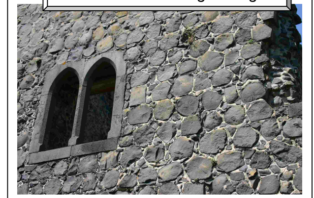
Ruine der Münzenburg (erbaut um 1300) Mauerwerk aus Hartbasalt-Säulen und Fenstergewände aus poröser Basaltlava
