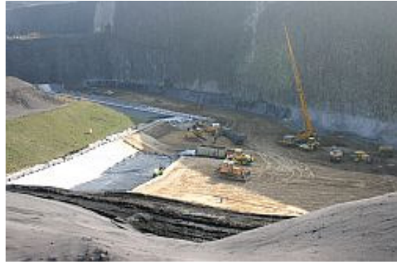
Der ausgebeutete Steinbruch wird verfüllt.
